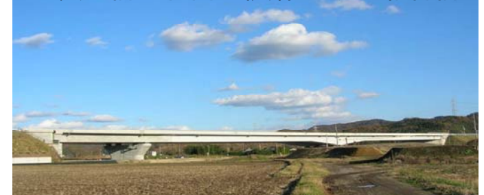
小貝川橋(3径間連続鋼PRC混合箱桁橋)
