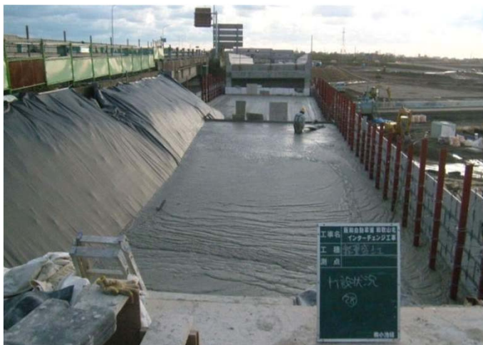
③エアーモルタル打設状況
