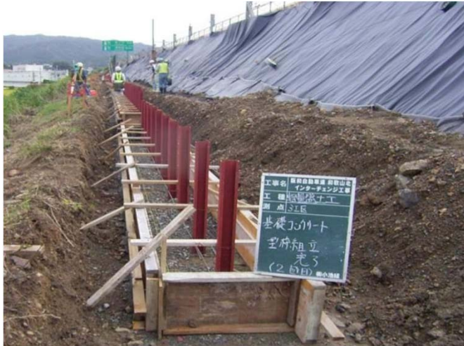
①基礎コンクリート型枠組立状況
