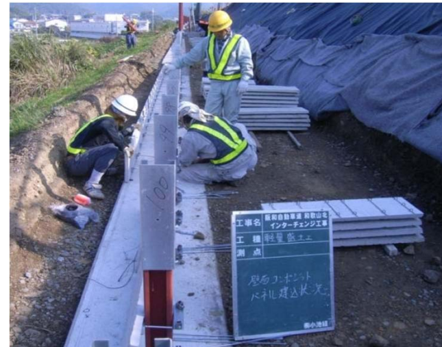
②壁面パネル組立状況
