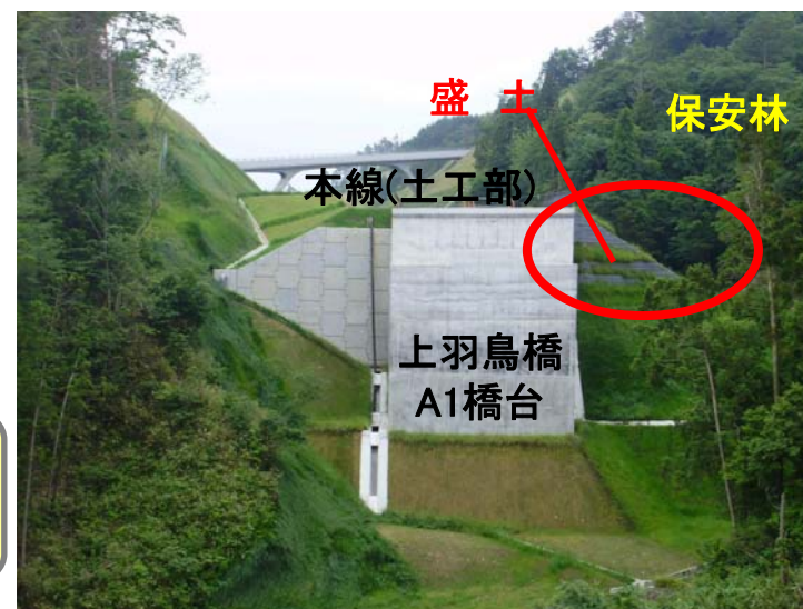
施工後(上羽鳥橋側より)
