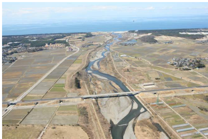
胎内川橋付近
