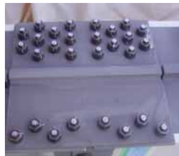
レール設置状況
