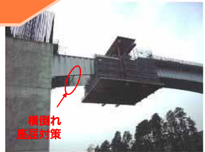
P 8 - P 9 橋脚波形ウェブ閉合後
