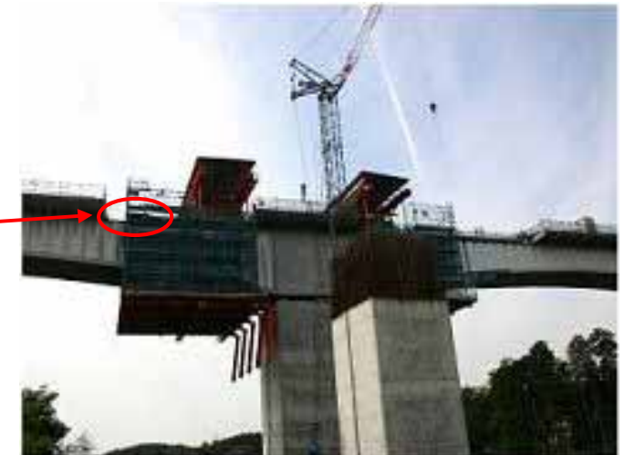
P 9 橋脚基部移動作業車据付後
