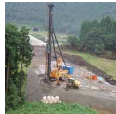
深層混合処理(セメント攪拌状況)
