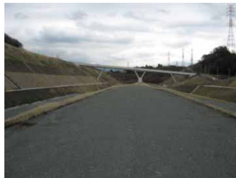
盛土完成状況
