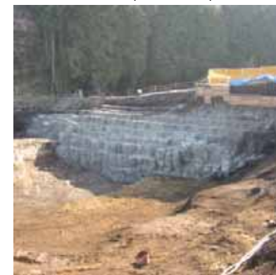
深層混合処理完了
