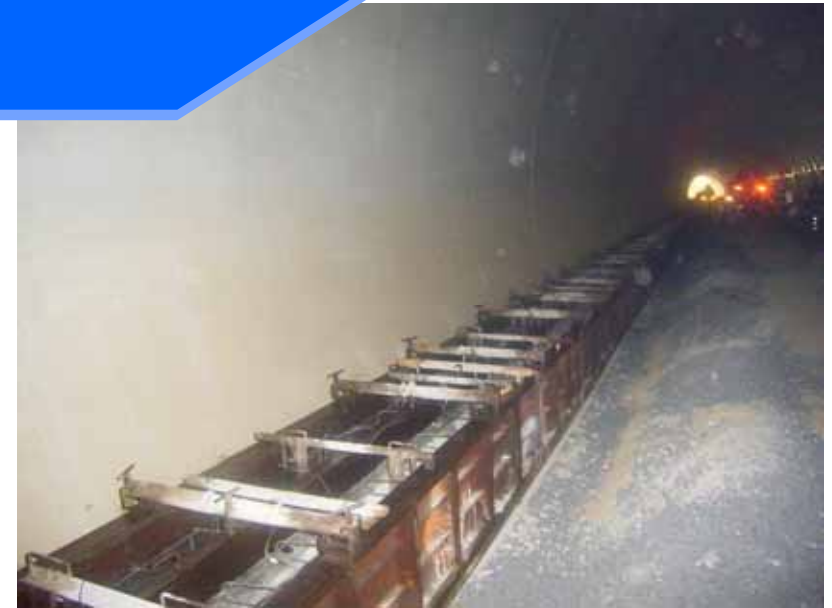
セットフォーム工法(型枠設置状況)
