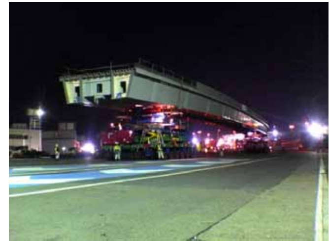
の特殊移動台車とリフトジャッキによる架設
