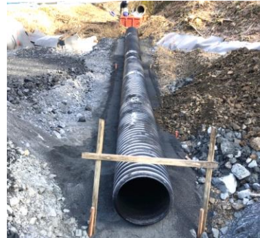
地下排水設置状況
