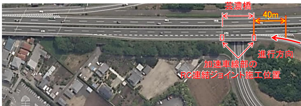
芸濃橋(上り線)航空写真
