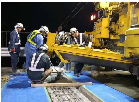
RC連結ジョイント施工状況
