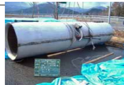
撤去したジェットファン
