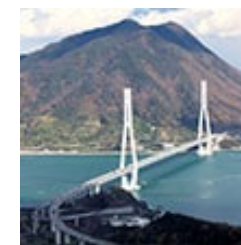
多々羅大橋
