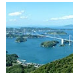
来島海峡第一・第二・第三大橋
