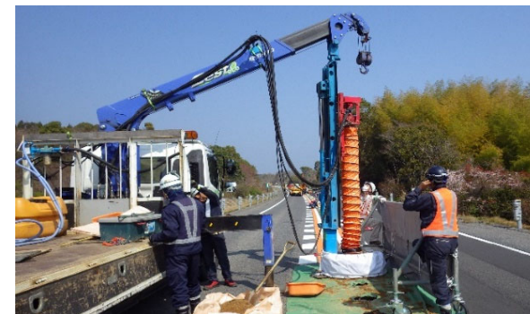
鋼管打込み状況
