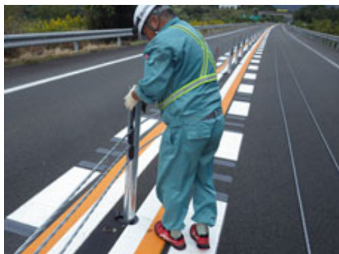
⑥ 支柱・ワイヤロープ設置
