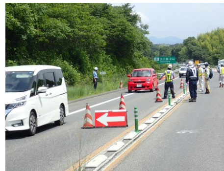
片交規制状況(高速隊確認立会)
