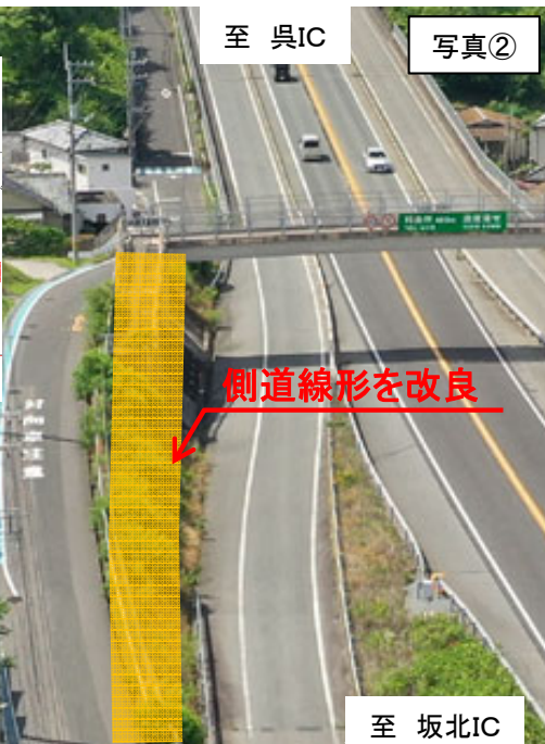
側道を拡幅(幅員5.0m → 6.5m)
