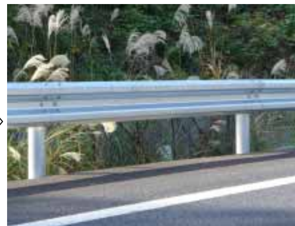
設置 現場へ運搬後、設置
