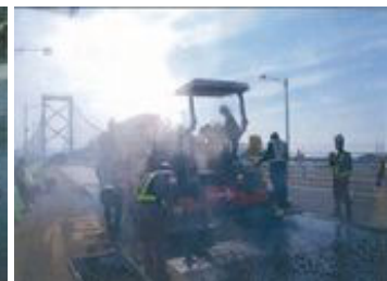
《基層グースAS舗設》
