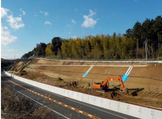
落石防護柵時の設置状況(先行利用)
