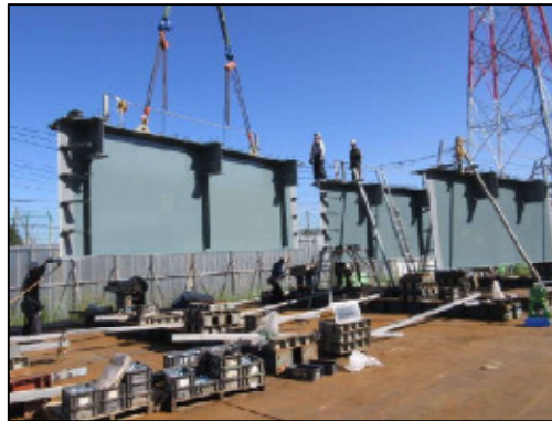
主桁の地組状況
