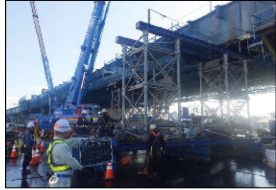
クレーンによる架設状況
