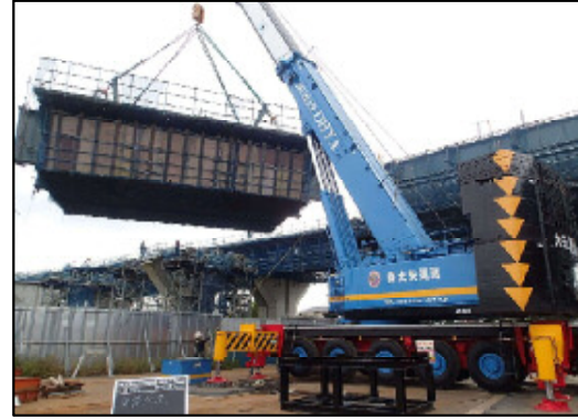
クレーンによる架設状況
