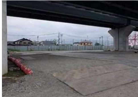
施工後に、碎石・敷鉄板を敷設
