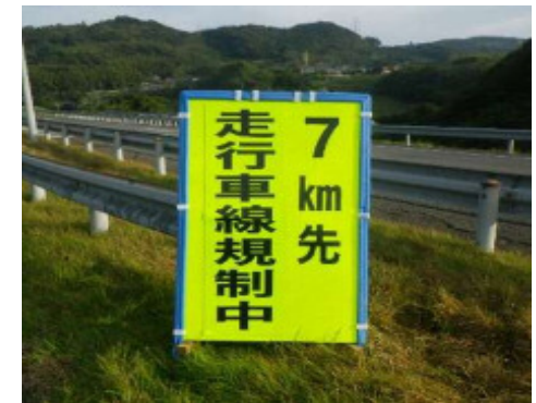
工事予告看板(7km手前)
