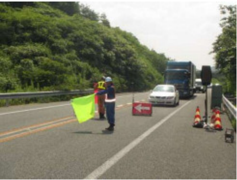
片側交互通行規制の様子
