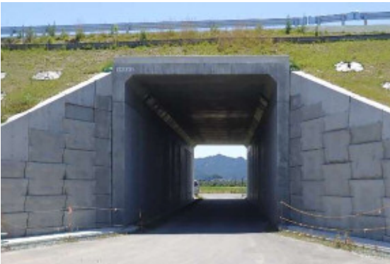
設置したカルバートボックス
