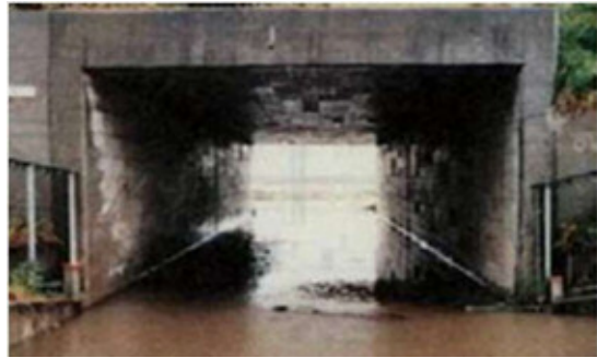
他路線における不具合事例 (カルバートボックス内の滞水)
