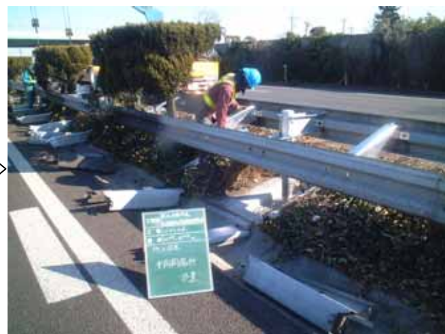
新材ブラケット、既設レール設置
