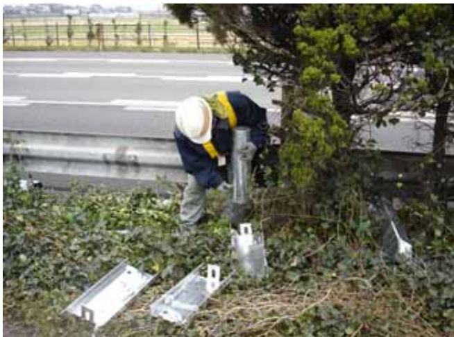
嵩上げ支柱( 127)の設置
