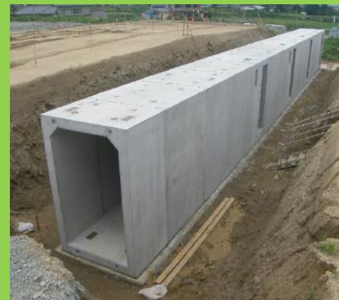
料金所地下ボックス
