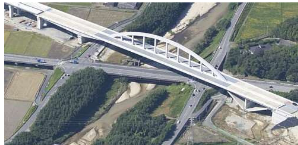
施工が完了した朝明川橋
