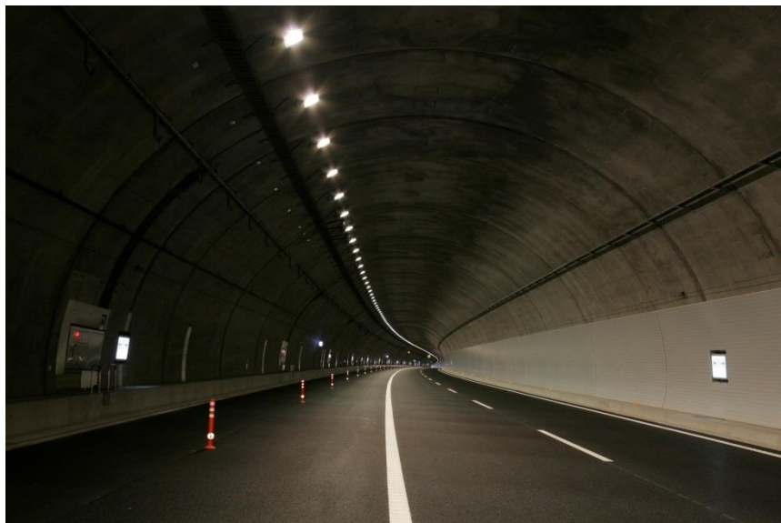
内側2車線運用(伊佐布トンネル上り)
