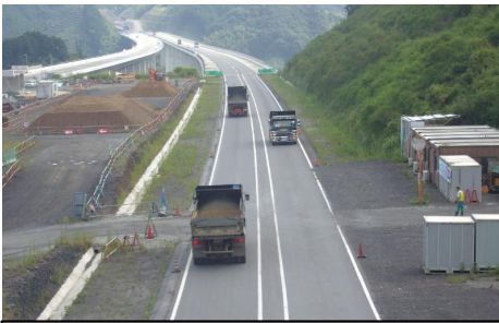
高速土運搬状況(土工部)
