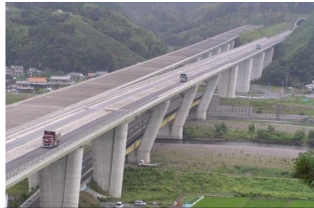
高速土運搬状況(橋梁部)
