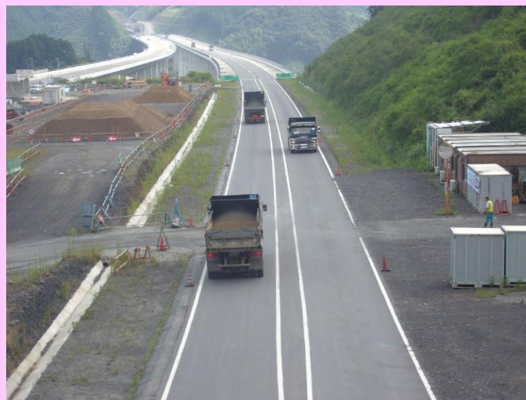
高速土運搬状況(土工部)
