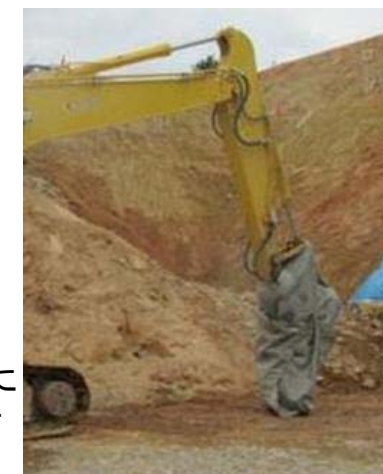
写真② 音楽設備の設置
