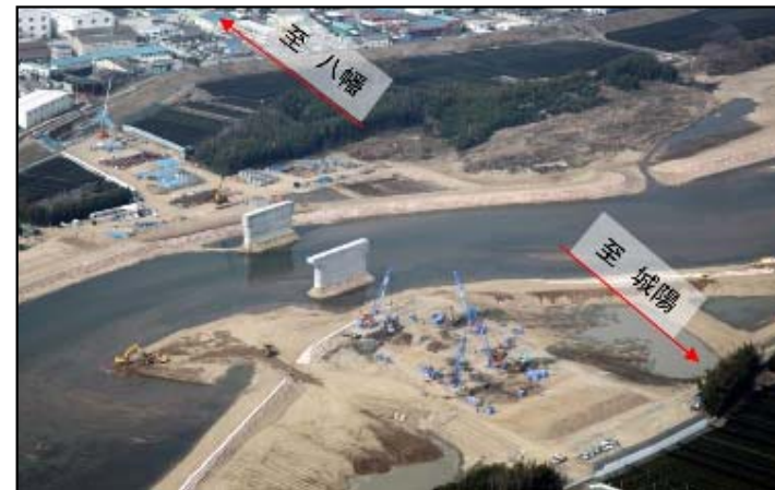
瀬替え施工状況
