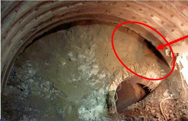
土砂化した箇所からの崩落
