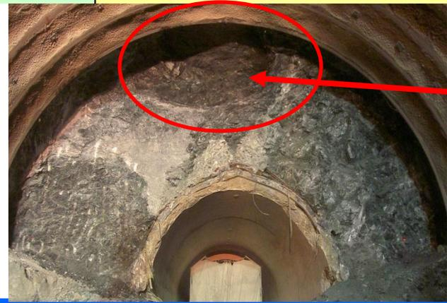
天端部からの剥落約3m³程度発生
