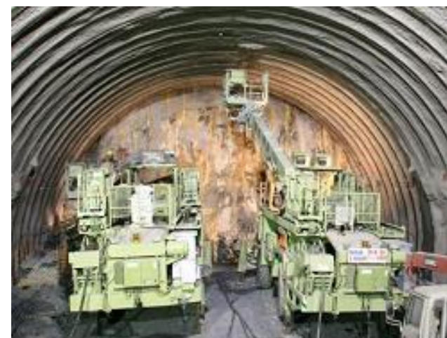
掘削機械の2セット化
