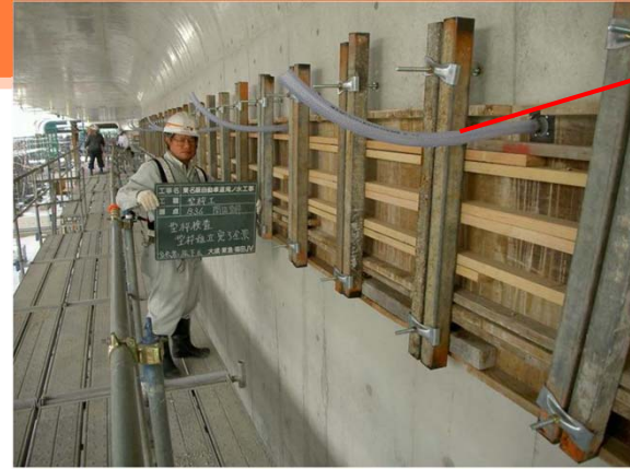
側壁部間詰型枠設置状況
