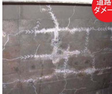
橋（床版）の損傷事例
