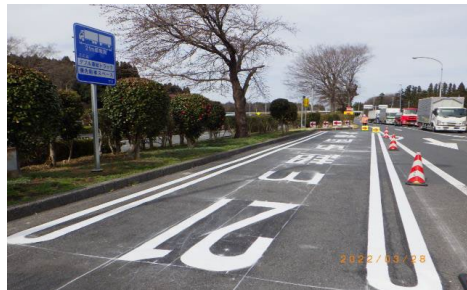
ダブル連結トラック駐車マスの整備状況 (E4東北道黒磯PA (上))
