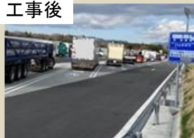
ダブル連結トラック駐車マスの整備状況
