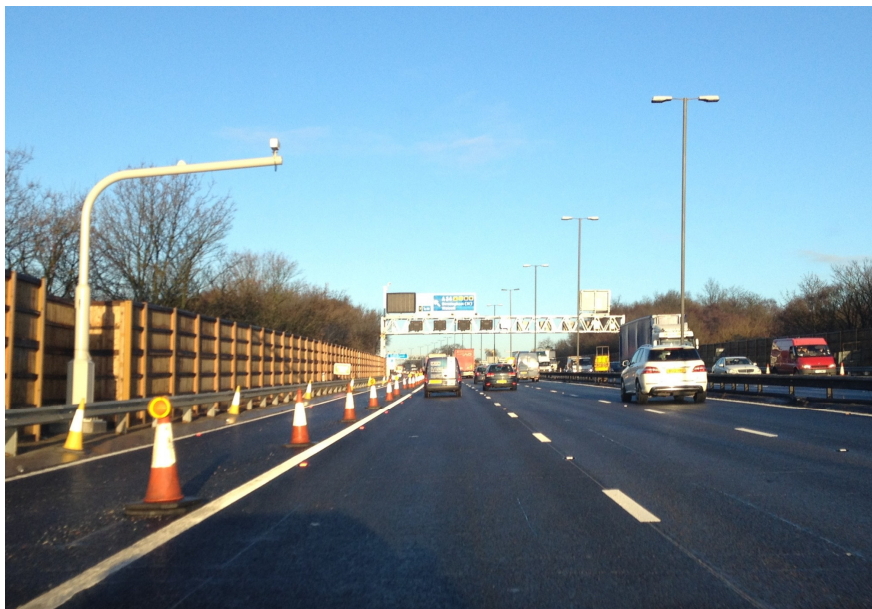
写真 C 管理型高速道路（バーミンガム市内・M6 道路）
