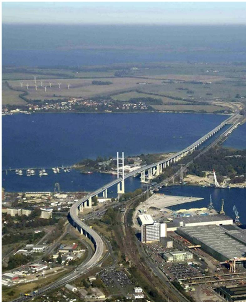
写真左側の斜張橋が新しいリュウゲン橋、右側が旧橋。手前のシュトラールズントの町から小島（デームホルム島）を経て対岸のドイツ最大の島（ドイツ北東部バルト海に位置する）リュウゲン島へと達する。新橋開通後も旧橋は使用されている。旧橋は、自動車、鉄道、歩行者用の橋からなる可動橋（跳ね橋）である。
