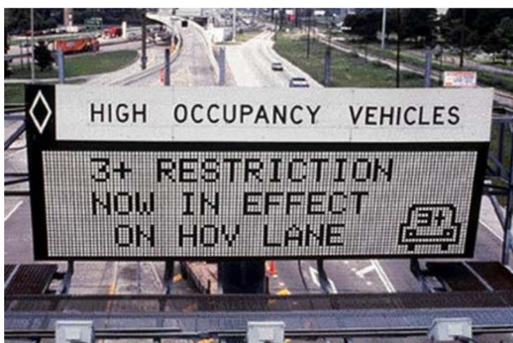
可変情報板の例：HOVレーンが、現在3人以上の乗車車両の通行に限定されていることを示している。
