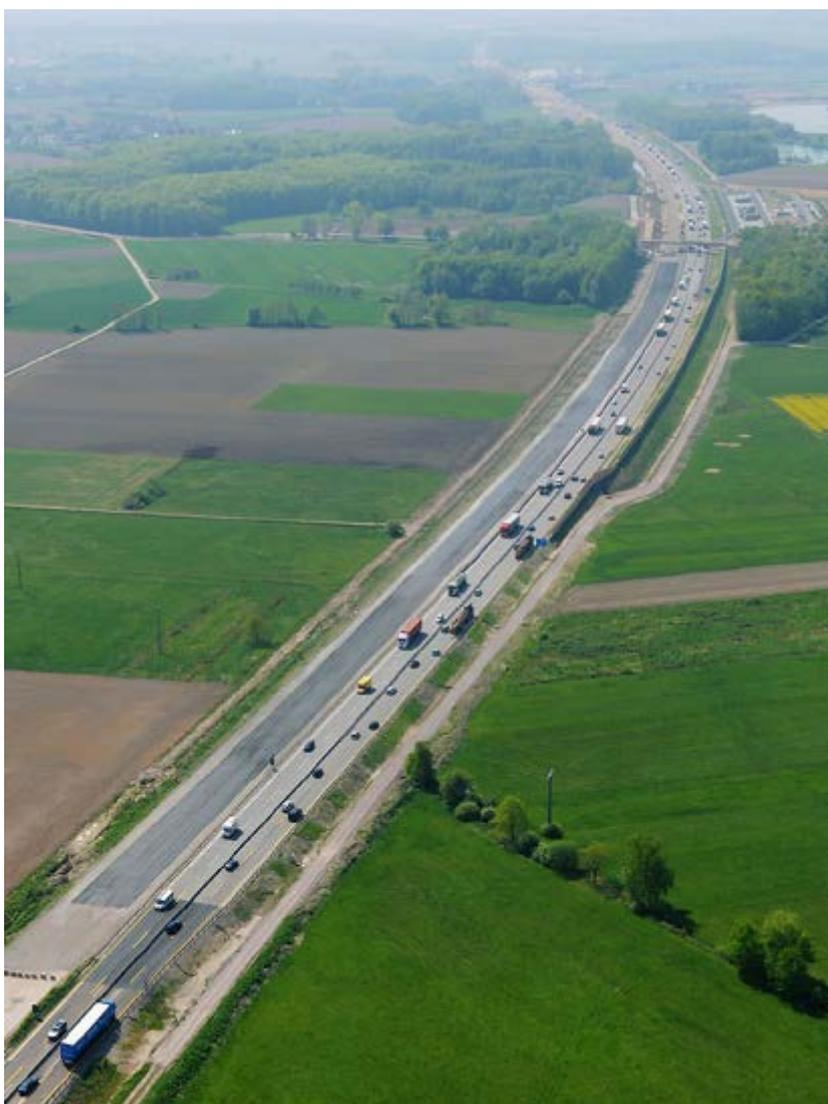
ドイツ : (p.99)アウトバーン A 5 号線の車線増設工事状況(事業対象区間延長は 60km)
