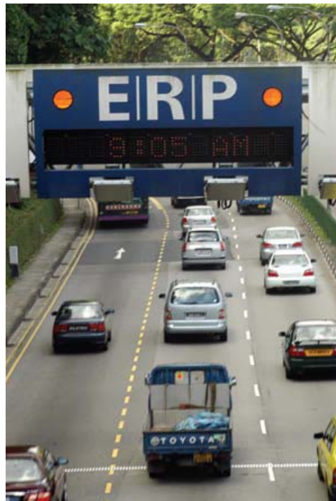
図 4-1 電子的道路課金(ERP)のガントリーの下を通過する交通(シンガポール)
