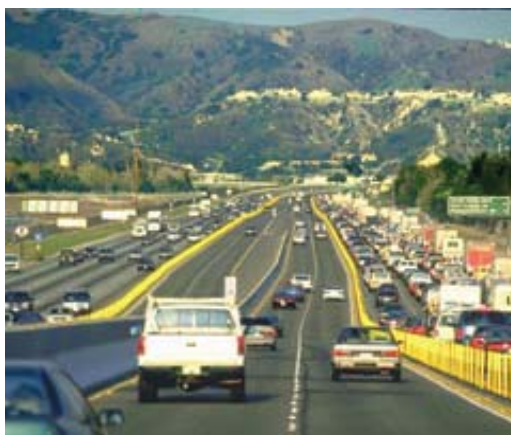
図3-1 SR91の有料レーンと無料レーン(プラスチックパイロンによる分離)
