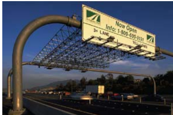
トランスポンダーは道路をまたぐアンテナによって読み取られ、 停止しないで料金を支払うことができる。
