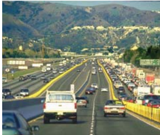
SR91では、プラスチック製のパイロンによって有料レーンと無料レーンが分離されている。
