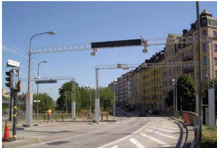
ストックホルムでは、電子的タグ・リーダーとカメラが道路をまたぐガントリーに設置されている。
