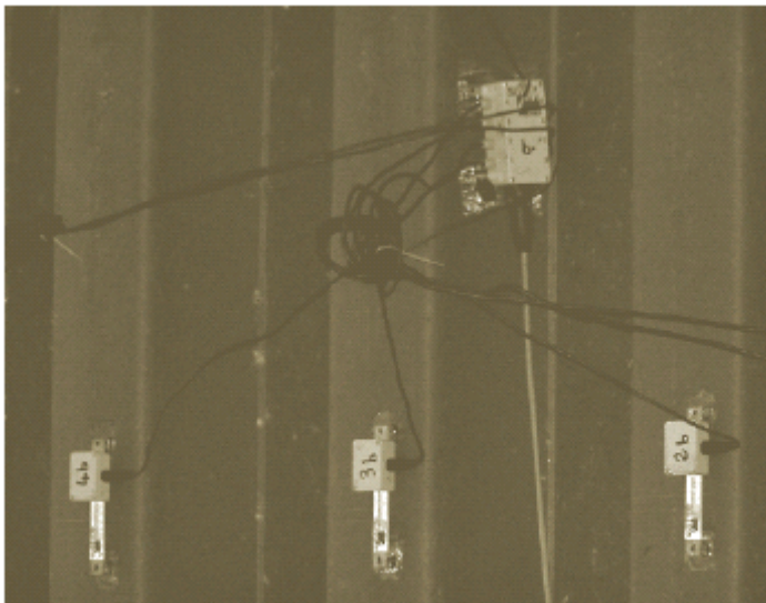
図 19 フランスにおける橋梁 WIM システム試験現場
