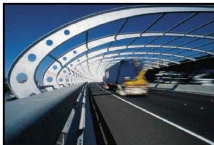
図表 4.5 メルボルン・シティ・リンクの騒音低減構造
