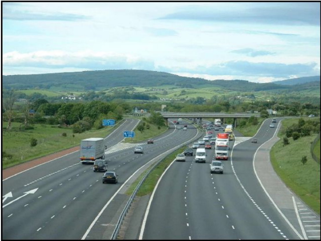
図表 3.4 カーンフォース付近の M6 有料道路
