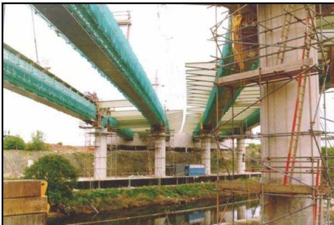
図表 3.13 建設中のエア渓谷高架橋
