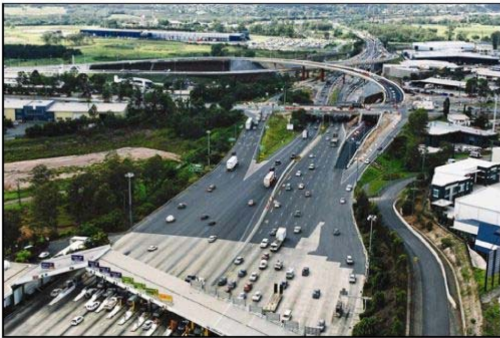
図表 4.22 ブリスベン港自動車道
