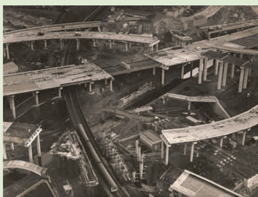
写真 2-1 1970 年代の工事の様子
