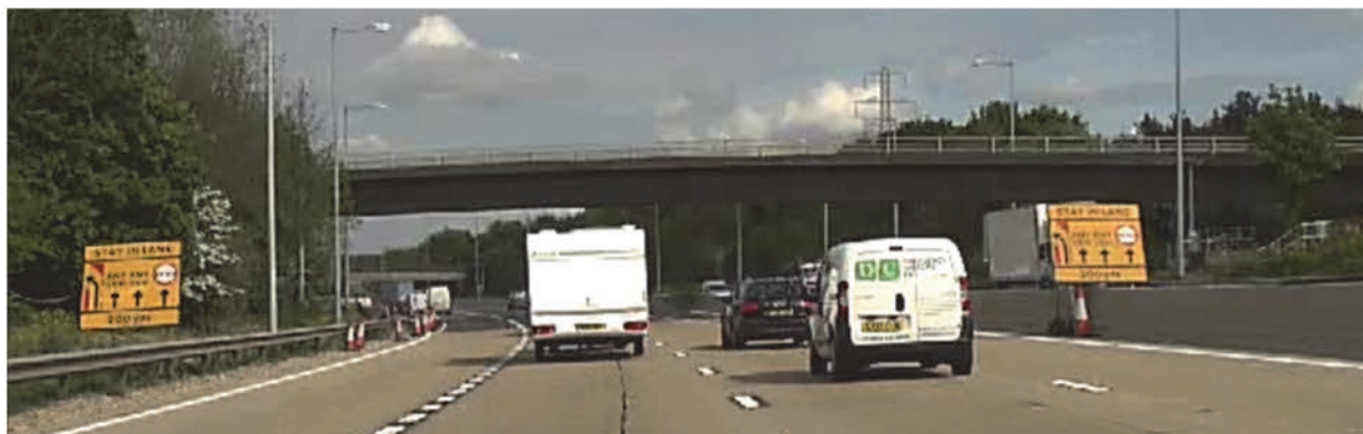
▲ 工事開始箇所
