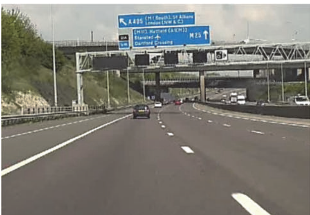
▲ 進入口には各車線に表示板が設置
