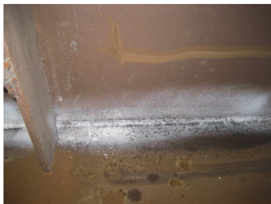
写真 2-3 ボックスガーター補修の状況
