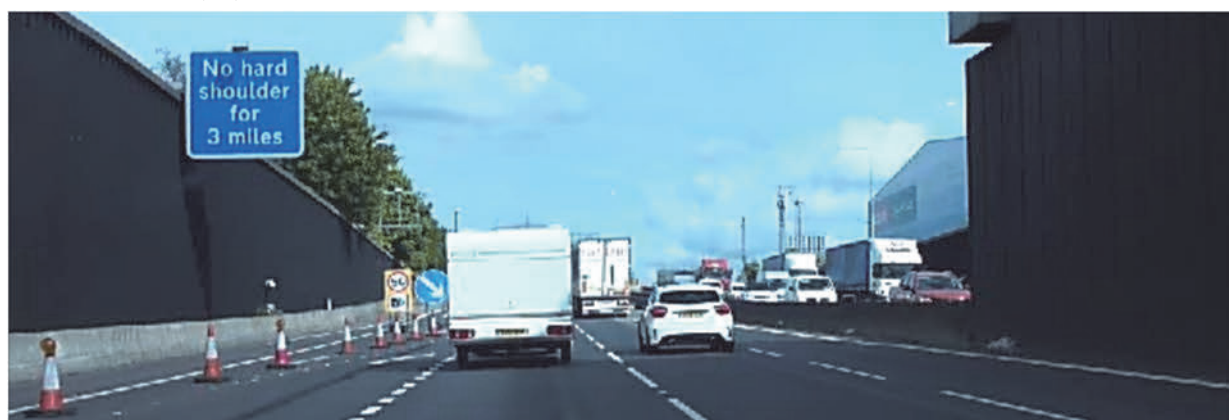
▲ 工事区間は3マイル路肩が（すでに）ありません
