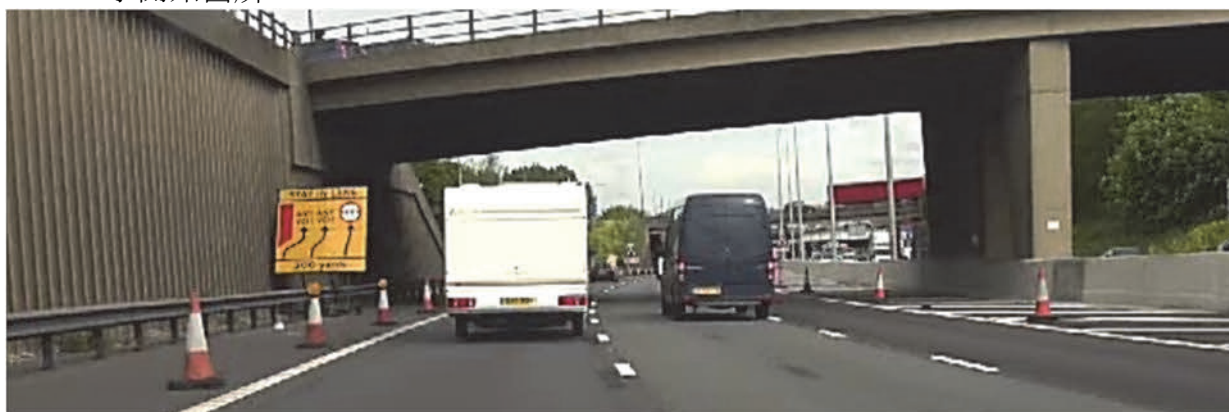
▲ 右側中央分離帯は工事が完成している
