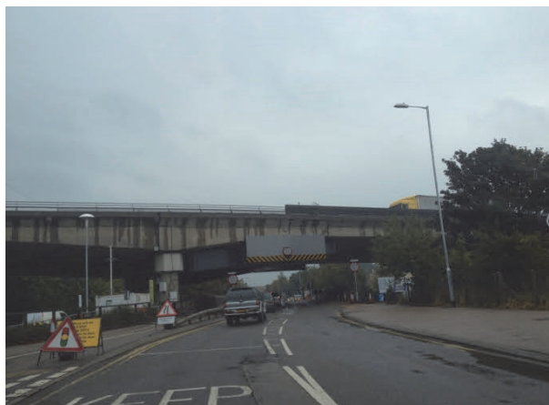
▲ B1514 ハンティンドン駅周辺 A14 が上を通る。4.4m の高さ制限あり この橋は改良事業後、廃止される予定
