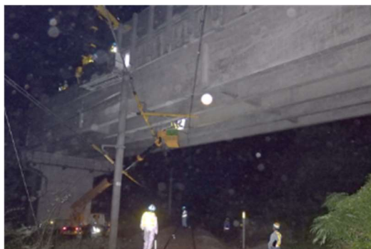
《橋梁下面の点検状況（鉄道交差）》
