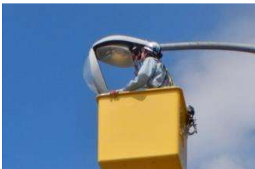
《道路照明の点検状況》
