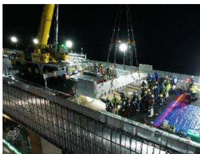
夜間通行止めによる床版取替
