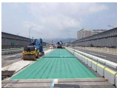
高性能床版防水設置
