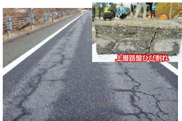
《路盤の変状を起因とする表層のひび割れ》
