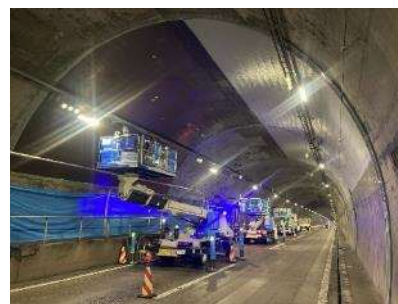
トンネル覆工補強
