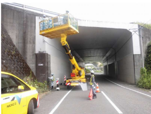
《ボックスカルバートの点検状況》
