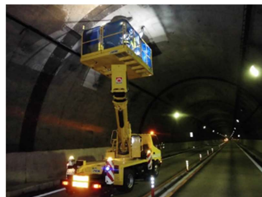
《トンネル覆工の点検状況》
