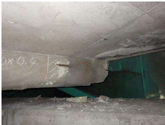
《桁端部補修（橋梁）》
