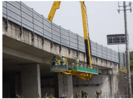
《橋梁下面の点検状況》
