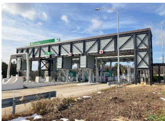
《料金所上屋通路》
