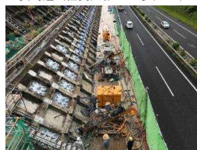
グラウンドアンカー設置
