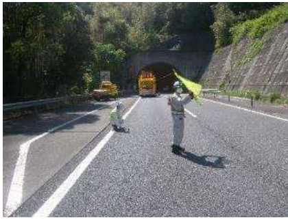
《路面の点検状況》
