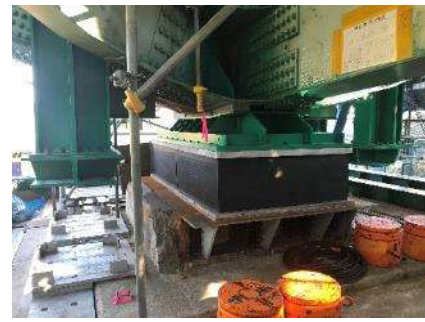
《補強後（支承取替）》
