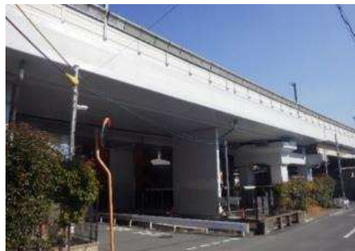
《橋梁上部工はく落対策（補修後）》
