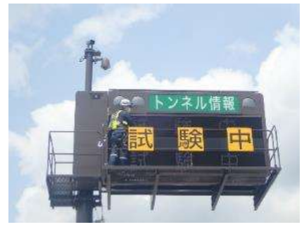
《情報板の点検状況》
