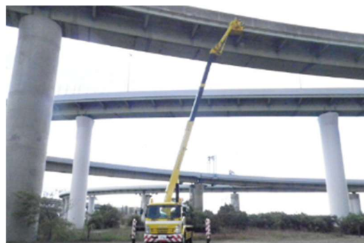
《橋梁下面の点検状況》
