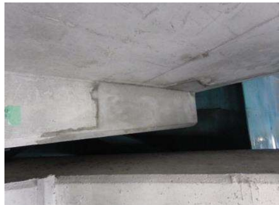
《桁端部補修（橋梁）》
