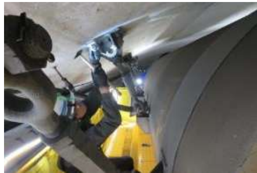
《トンネル換気設備の点検状況》
