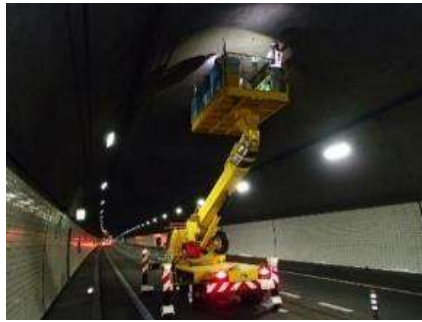
《トンネル覆工の点検状況》
