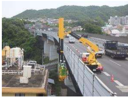
《遮音壁の点検状況》
