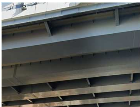
鋼桁の塗替塗装施工状況
