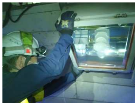
トンネル照明設備点検
