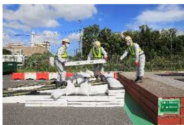
開き修正材の設置状況
