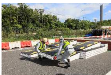
段差修正材の設置状況
