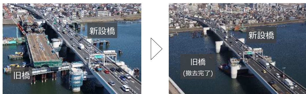
旧橋（桁）撤去完了状況
