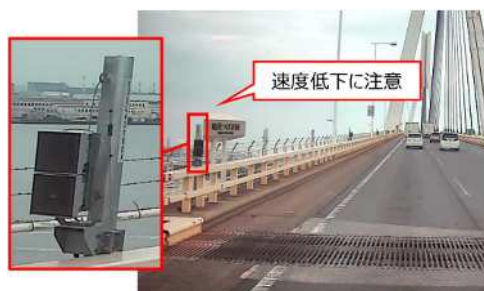
指向性スピーカーを用いた速度低下抑制対策（湾岸線東行き鶴見つばさ橋）
