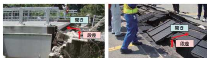
橋梁損傷事例
