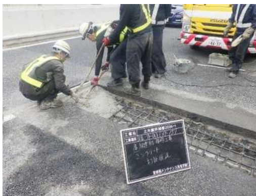
長時間車線規制工事の実施状況（ノージョイント化工事）
