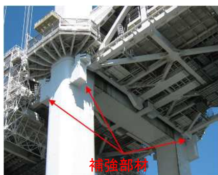
長大橋の耐震補強 (レインボーブリッジ主塔下路部の補強)
