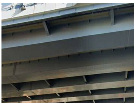
鋼桁の塗替塗装施工状況
