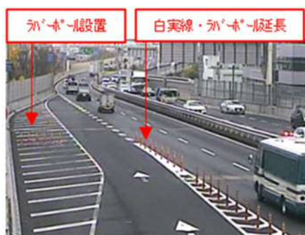
ラバーポールの設置、白実線の延長 （4号新宿線（下り）西新宿 JCT）
