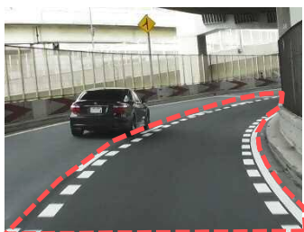
舗装打換え 減速レーンマーク
