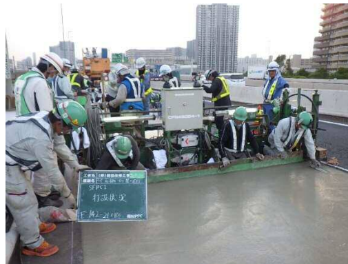
長時間車線規制工事の実施状況（SFRC 舗装工事）
