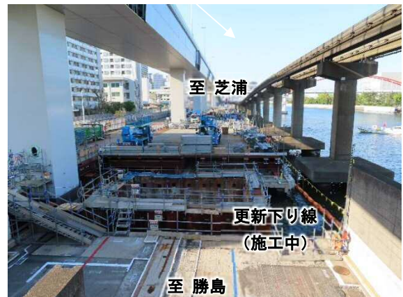
下り線施工状況
