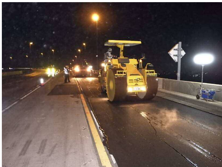
舗装工事実施状況
