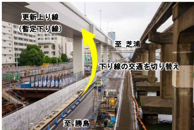
上り線切り替え状況
