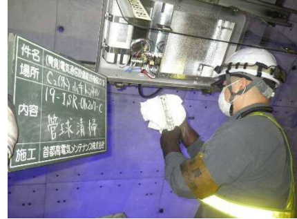
トンネル照明設備点検
