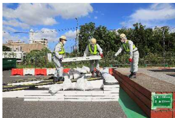
開き修正材の設置状況
