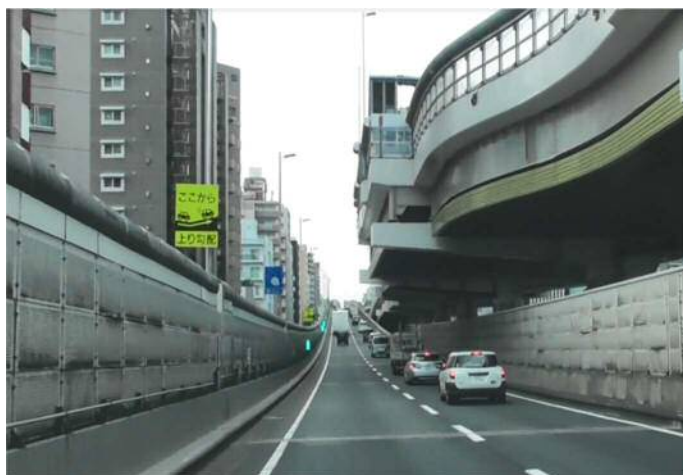
注意喚起板の設置
