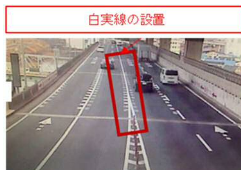
車線境界線の白実線化 （中央環状線（内回り）堀切 JCT）
