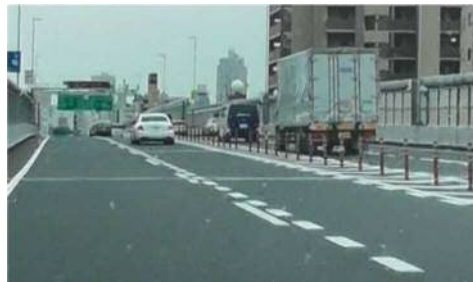
減速レーンマーク施工
