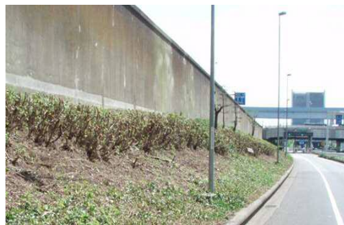
道路路肩脇の植樹の伐採後
