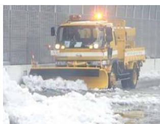
除雪作業の状況
