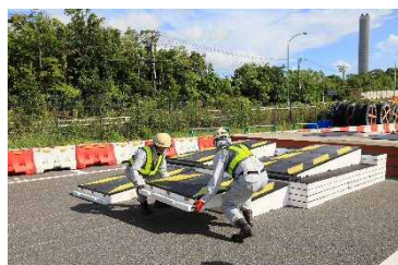
段差修正材の設置状況
