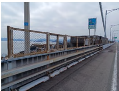
立入防止柵（補修前）
