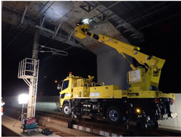
JR軌道上高架橋の打音点検
