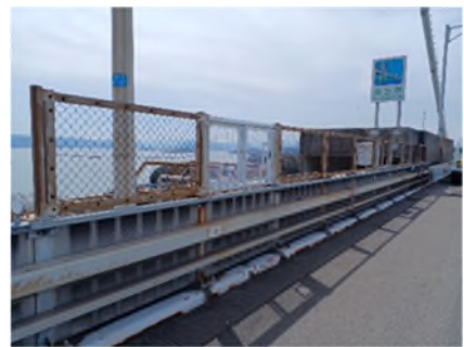
立入防止柵（補修後）
