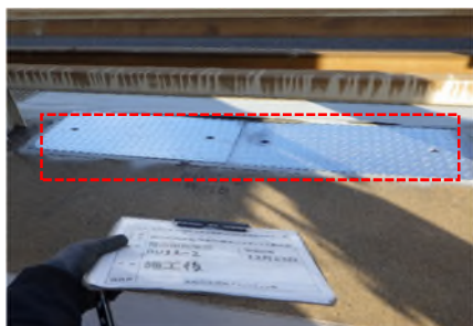
橋梁配線用プルボックス（補修後）
