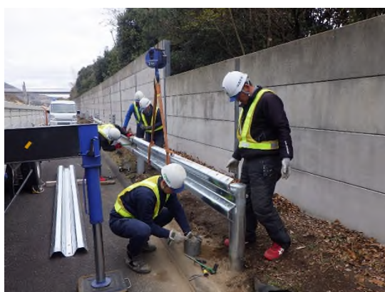
ガードレール取付工事
