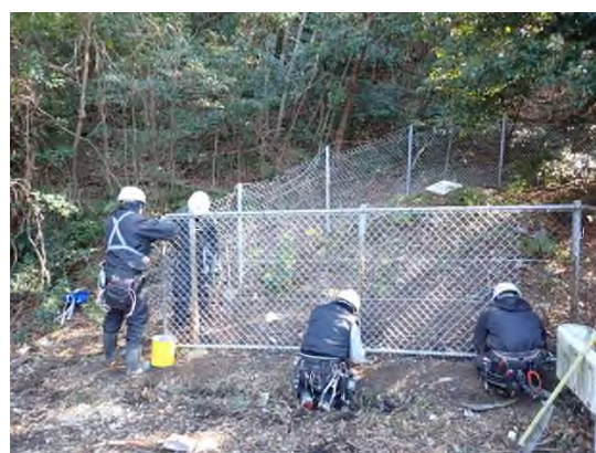
立入防止柵補修工事
