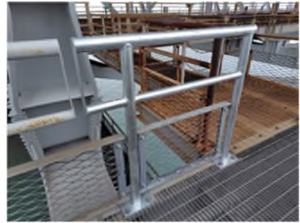
管理用通路（補修後）
