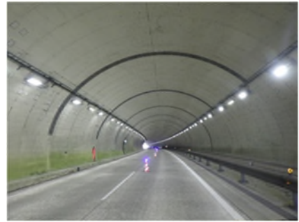
トンネルはく落対策（補修後）
