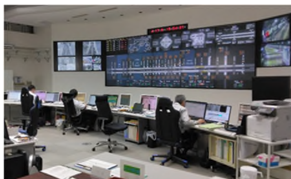
管制室の状況
