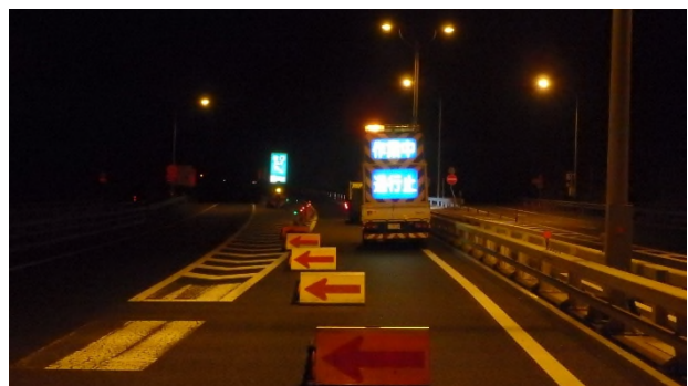
規制車による通行止め状況
