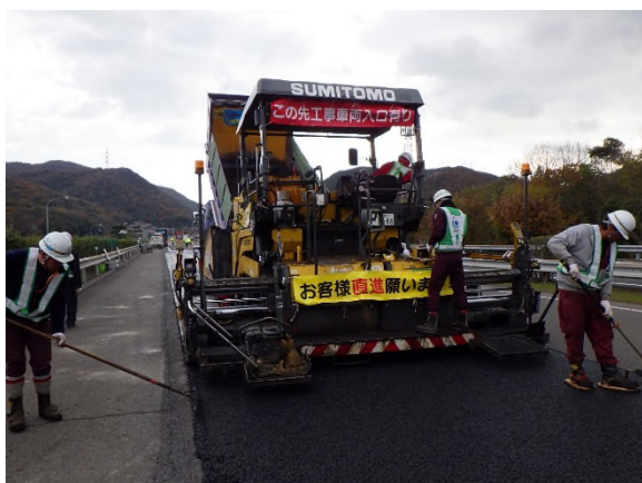
舗装補修工事（切削オーバーレイ工）
