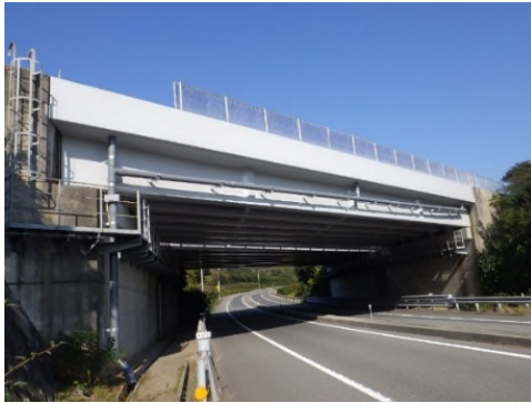
橋梁（桁）の表面被覆工施工状況
