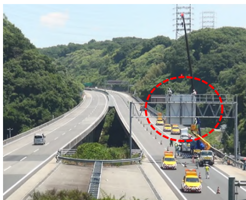
低速走行規制による大型標識撤去作業(左が撤去中、右が撤去完了)
