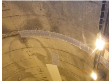
トンネルはく落対策(補修後)
