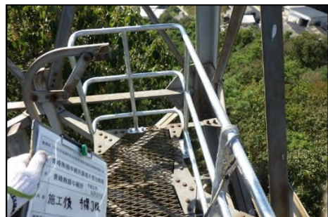
無線鉄塔手摺り部 (補修後)
