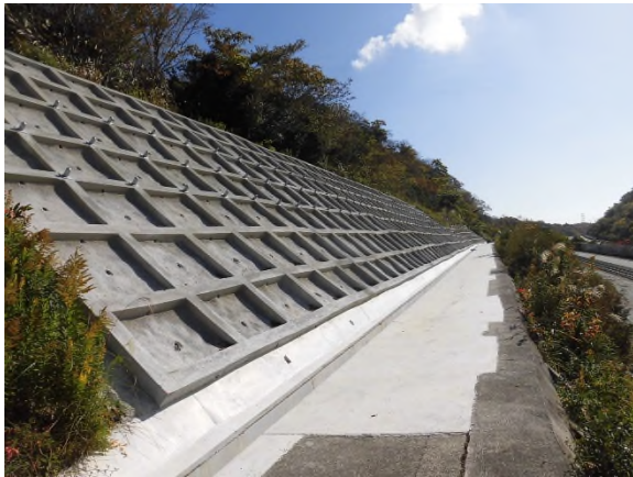
のり面防災対策（のり枠工）
