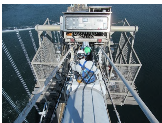
点検状況（長大橋）
