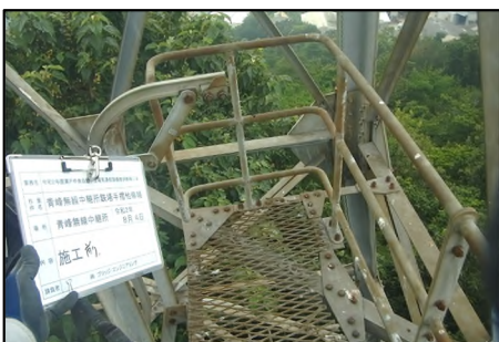
無線鉄塔手摺り部 (補修前)
