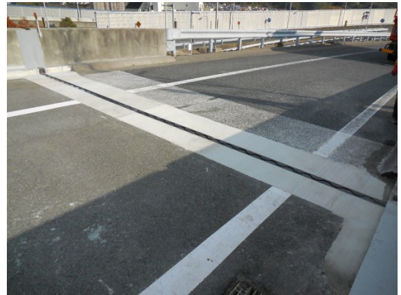
伸縮装置取替
