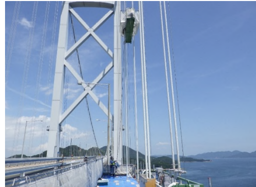
吊橋ハンガーロープの塗替塗装状況 (一般国道 317 号 因島大橋)
