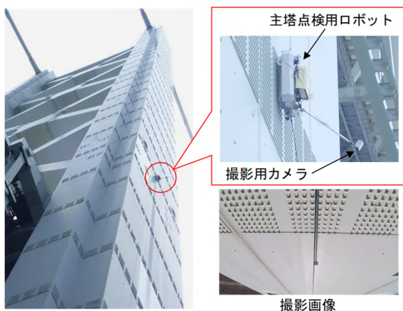
主塔点検用ロボットの検討
