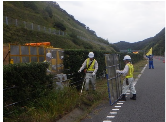
植栽管理（中央分離帯草刈り）
