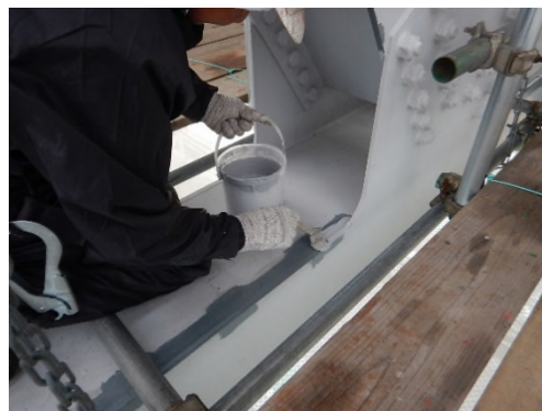
大鳴門橋局部補修塗装実施状況
