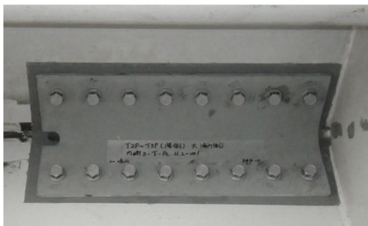
鋼床版下面からの亀裂補修方法
