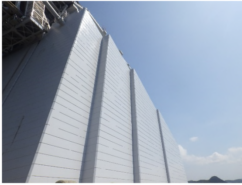
大鳴門橋コンクリート補修完了
