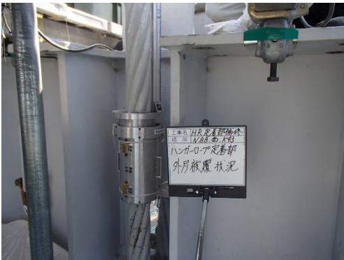
瀬戸大橋ハンガーロープ補修状況
