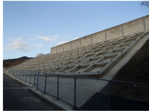
土構造物 盛土のり面補強
