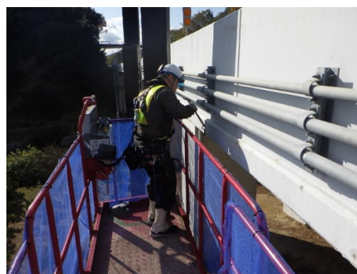
点検状況（電気通信施設）
