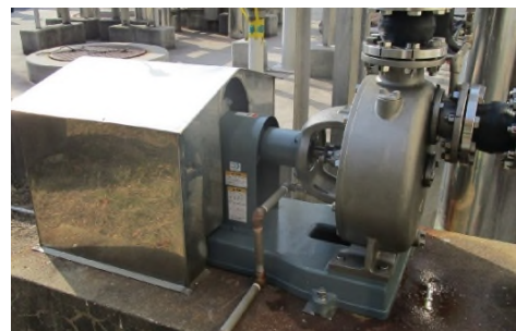
移送ポンプ修繕 (補修後)
