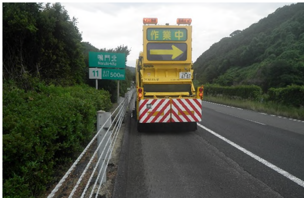
清掃作業（路面清掃）
