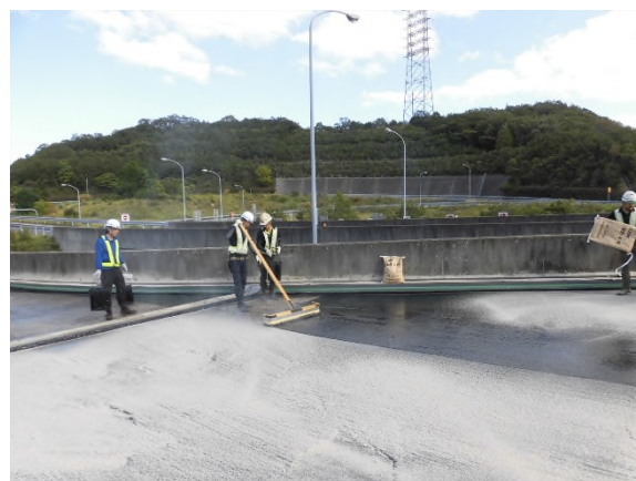
舗装補修工事（床版防水工）
