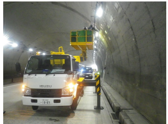
緊急対応（目地部剥落対策）
