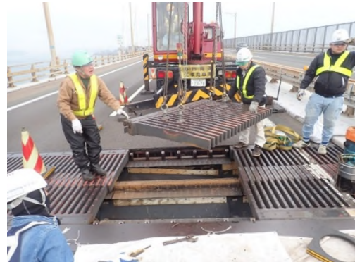
瀬戸大橋伸縮装置補修状況
