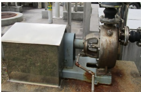
移送ポンプ修繕 (補修前)
