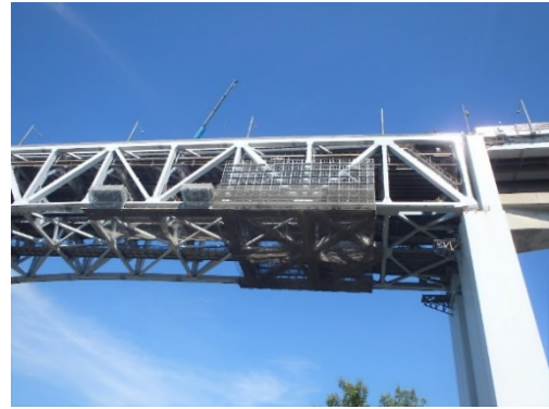
大鳴門橋局部補修塗装実施状況
