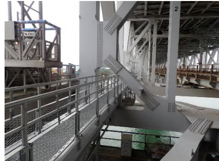
管理用通路(補修後)
