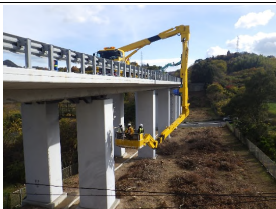
点検状況（土木）
