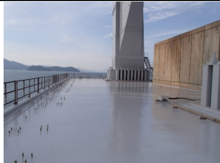
主塔基礎コンクリート塗装 (補修後)
