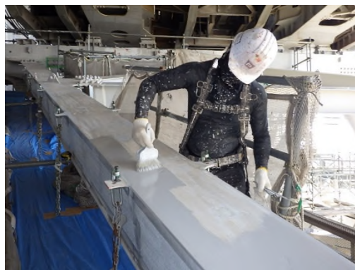
塗替塗装状況 （一般国道 30 号 瀬戸大橋）
