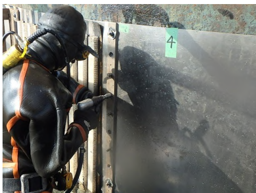
大鳴門橋多柱基礎防食実施状況
