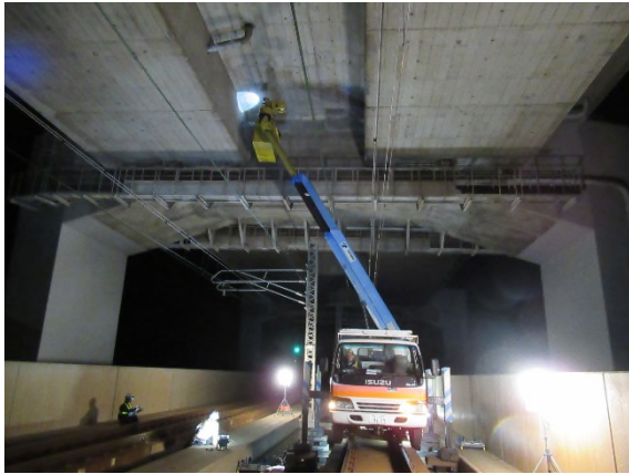
ＪＲ軌道上高架橋の打音点検
