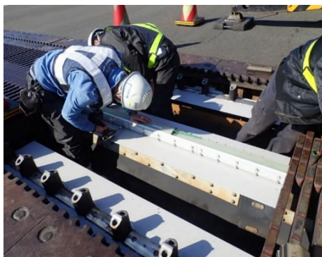
大型伸縮装置の補修 (一般国道 30 号 瀬戸大橋)
