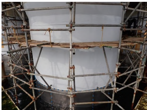
3P 飛沫部塗装、干満部チタンカバー設置状況 (一般国道 28 号 大鳴門橋)
