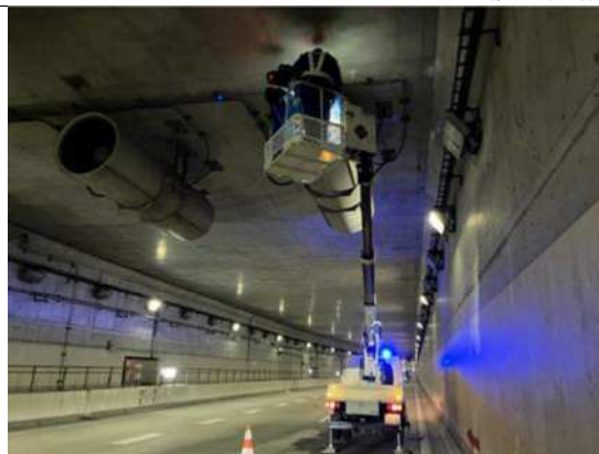
トンネル換気設備定期点検
