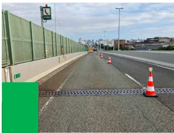
舗装補修（補修前）
