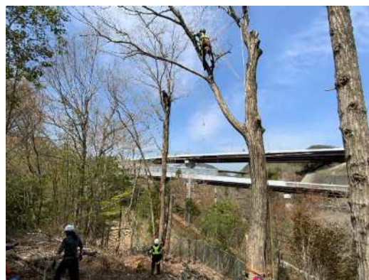
雑木伐採作業状況
