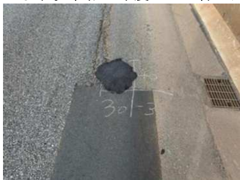
ポットホールの緊急対応の様子
