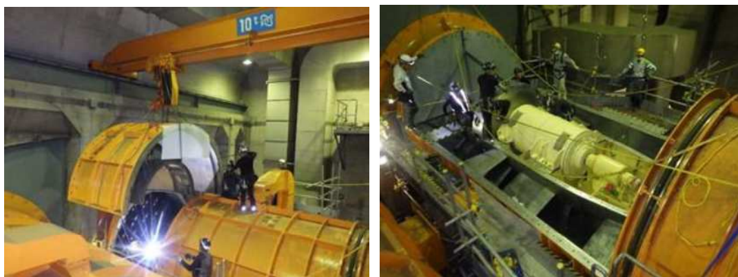
排風機 分解整備
