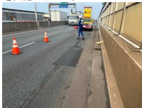
ポットホールの緊急対応の様子
