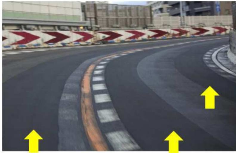
※車輪通過部に滑り止めを舗装 カーブ区間における滑り止め対策
