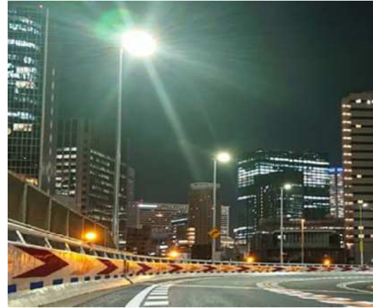
本線道路照明の取り替え後
