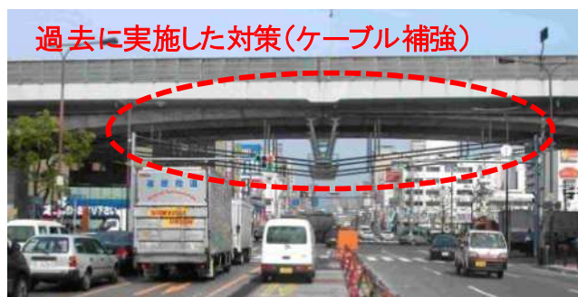
従来のケーブル補強状況
