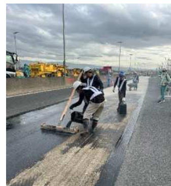
高性能床版防水施工状況
