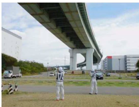
日常点検（路下）
