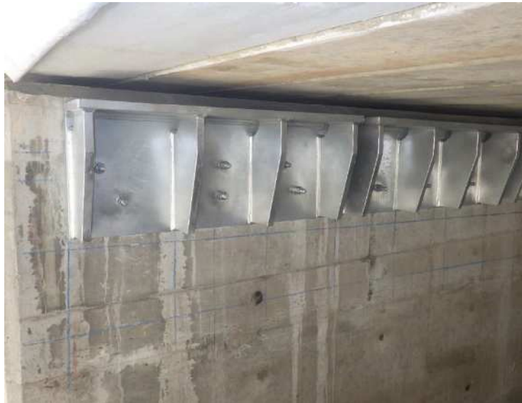
上部工の耐震補強
