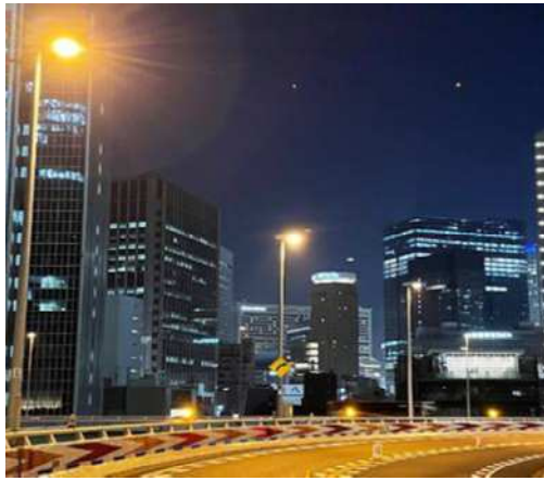
本線道路照明の取り替え前
