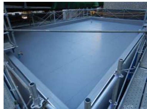
信濃橋倉庫屋上防水（補修後）
