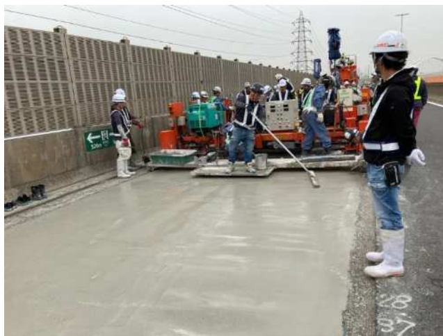
SFRC 舗装施工状況
