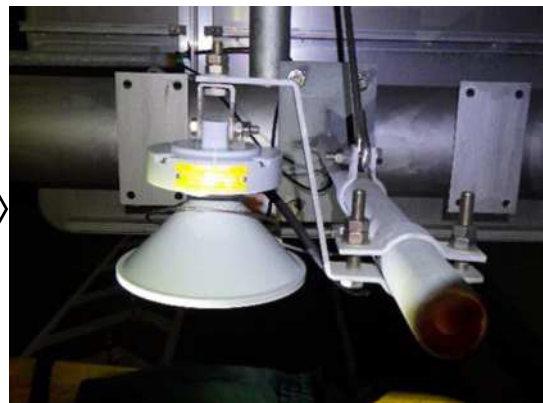
車両検知ヘッド補修後
