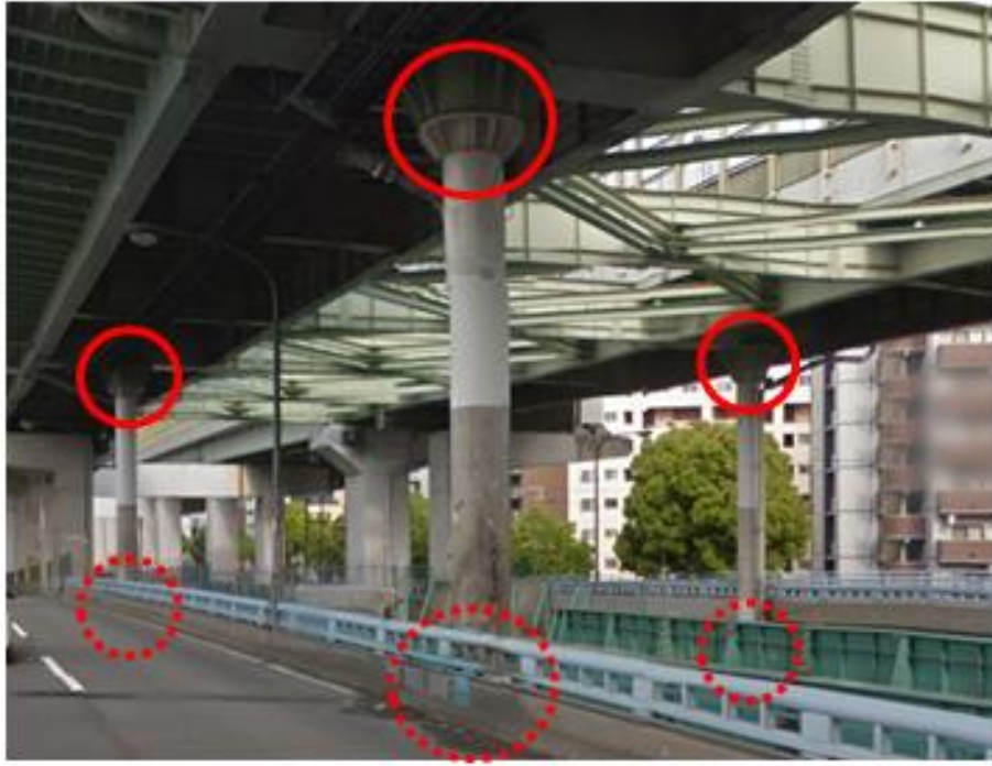
特殊橋脚の補強（ロッキング橋脚）
