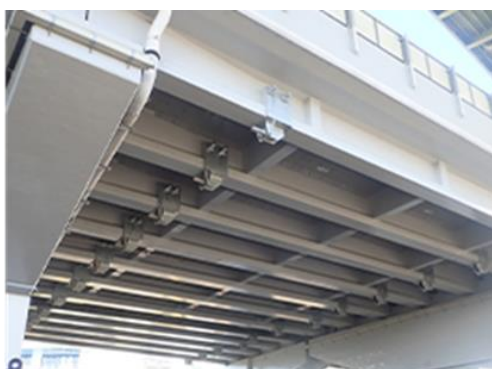
PC 桁外ケーブル補強状況
