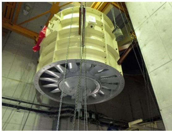
神戸長田トンネル南行 中央換気所排風機分解整備
