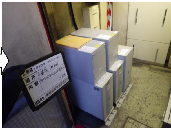
料金所無停電電源装置補修後
