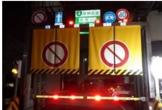
助松入口への設置例
