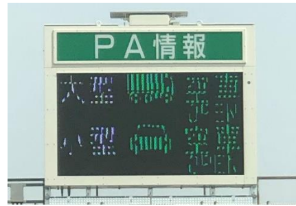
満車表示板の設置
