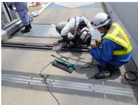
車両重量計設備定期点検
