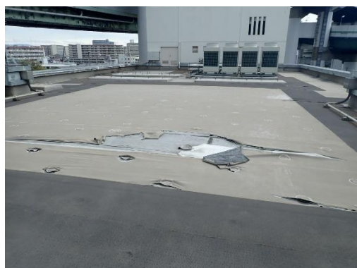
湾岸管理所第一社屋屋上（補修前）
