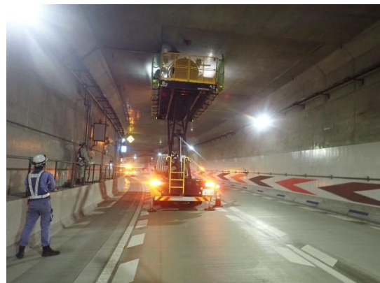
トンネル換気設備定期点検
