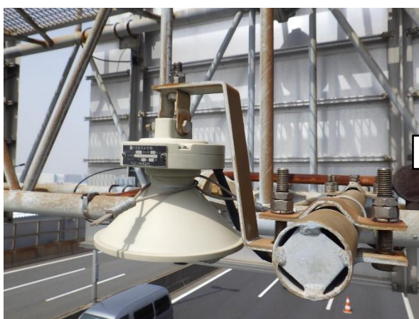
車両検知ヘッド補修前
