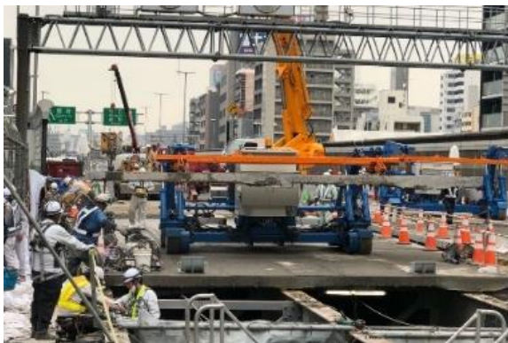
超高強度繊維補強コンクリート床版の工事（阪神高速12号守口線本線）
