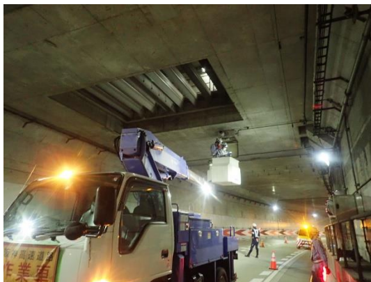
トンネル換気設備定期点検
