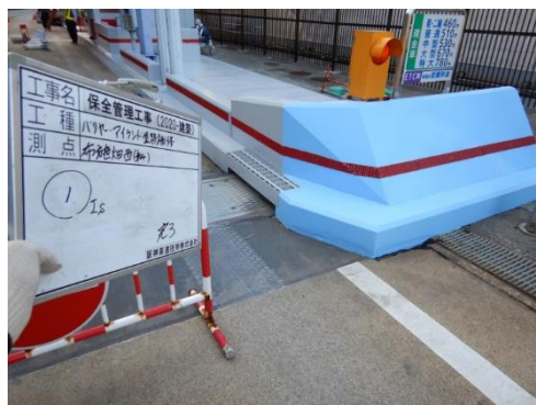
料金所アイランド損傷（補修後）
