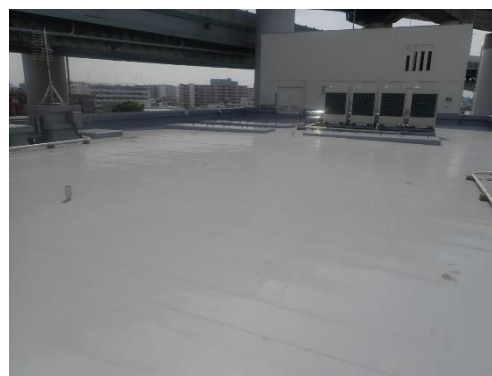
湾岸管理所第一社屋屋上（補修後）
