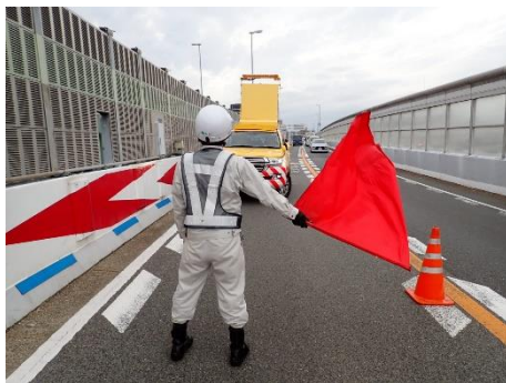
日常点検（路上）
