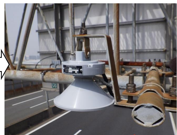
車両検知ヘッド補修後
