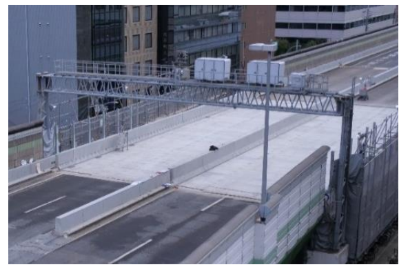
超高強度繊維補強コンクリート床版の工事（阪神高速12号守口線本線）
