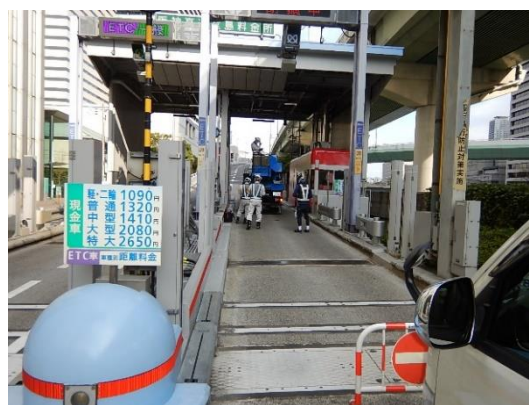
料金所の点検実施状況
