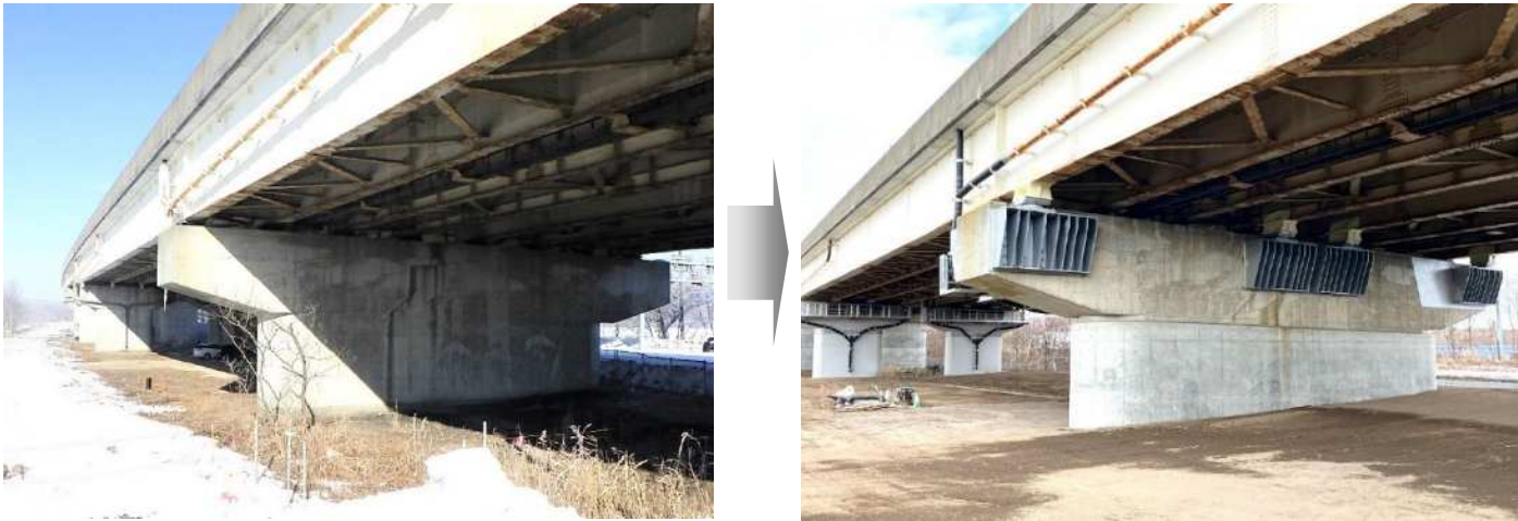
【補強前後の橋脚（日高道 植苗高架橋）】
