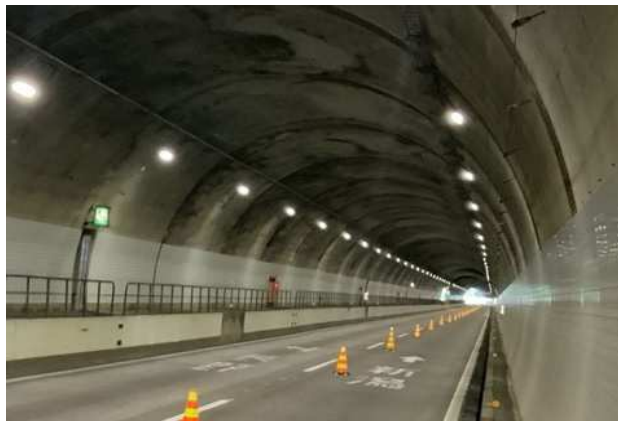
【トンネル照明設備の更新（LED 化） 北陸自動車道 名立谷浜 I C～上越 I C 春日山トンネル】
