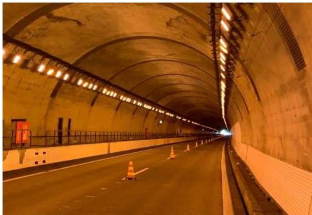
【トンネル照明設備の更新（LED 化） 北陸自動車道 名立谷浜 I C～上越 I C 春日山トンネル】
