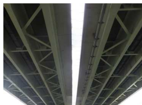
【塗装劣化部の塗替塗装 東京湾アクアライン連絡道 木更津金田 IC～袖ヶ浦 IC】
