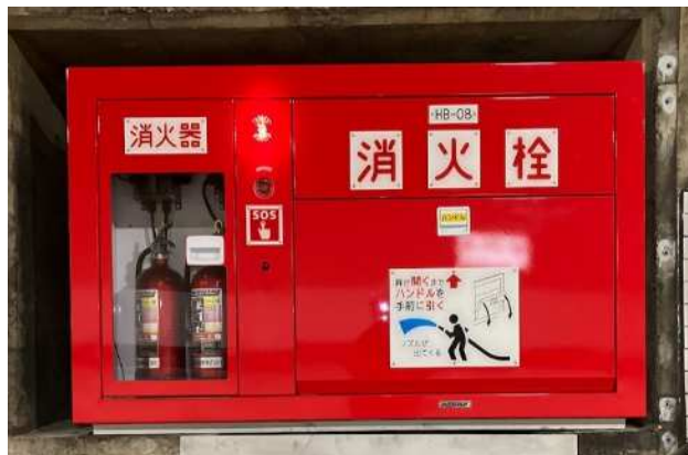
【消火栓設備の更新 常磐自動車道 いわき中央 I C～いわき四倉 I C 好間トンネル】
