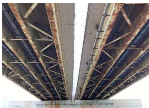
【塗装劣化部の塗替塗装 東京湾アクアライン連絡道 木更津金田 IC～袖ヶ浦 IC】
