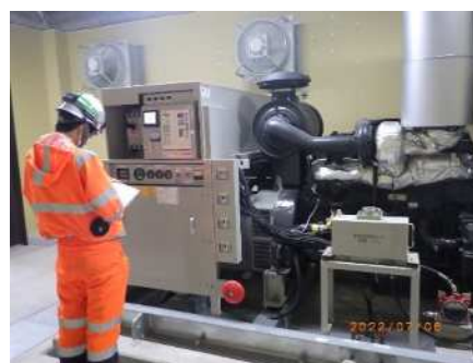
【自家発電設備の点検（施設）】
