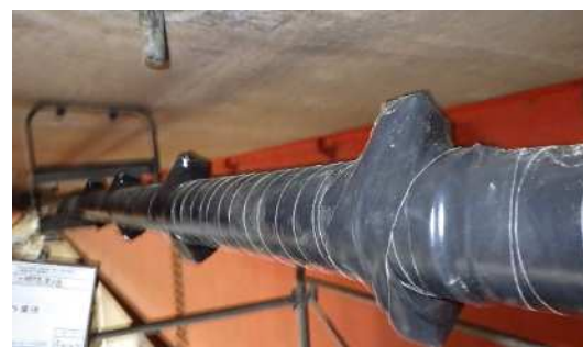
【緊急補修が必要な管路損傷の補修状況（施設）】
