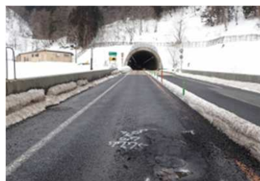
【緊急補修が必要な路面損傷の補修状況（土木）】
