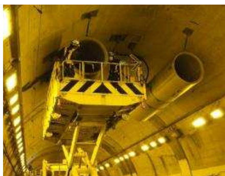
【トンネル換気設備の点検（施設）】
