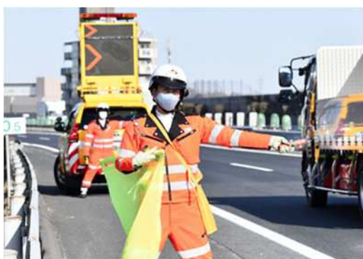
【路上障害物対応状況】
