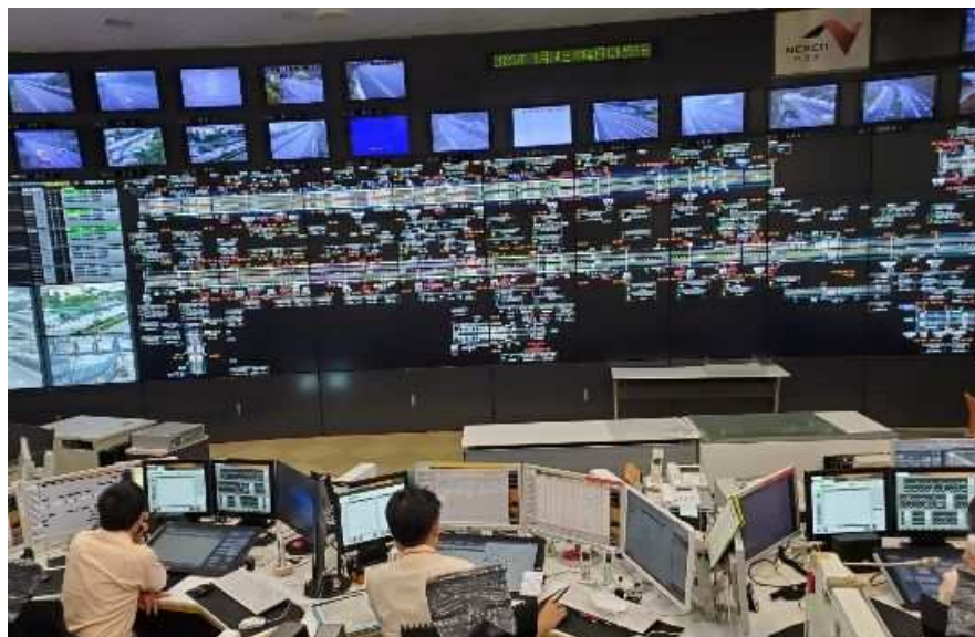
【道路管制センター】
