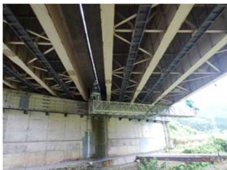
【従来の橋梁点検「橋梁点検車を活用」】
