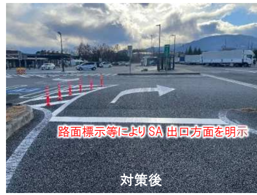
【E20中央道 双葉 SA 下りにおける対策状況(路面標示(矢印)、ラバーポールの施工)】
