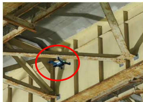
【ドローンを活用した橋梁点検(飛行状況)】
